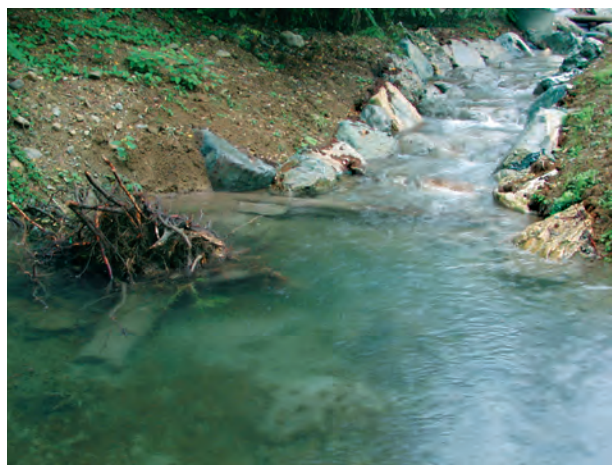
Dall'alto al basso: sbarramento lungo un nostro corso d'acqua; dislivello puntuale sul fiume Ticino a Quinto (zona Serte); interventi di diversificazione dell'alveo di magra sul fiume Roncaglia a Novazzano; lavori nel meandro del Ghitello, sul fiume Breggia.
