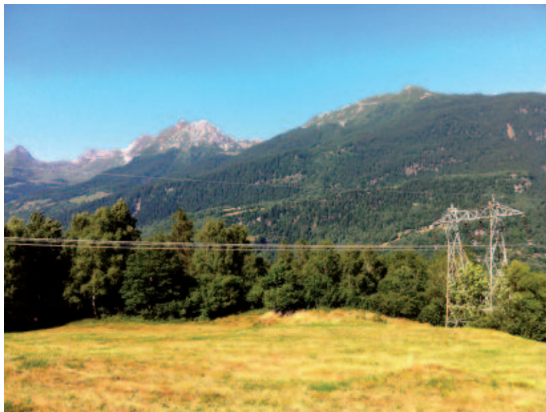
Linee elettriche ad alta tensione, una trappola mortale per il gufo reale.
