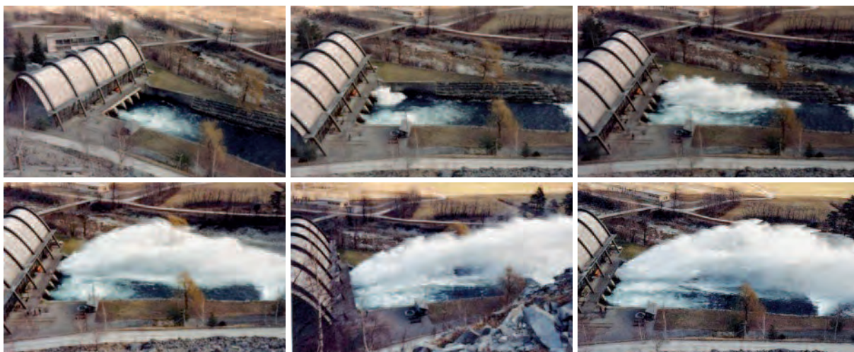
Fig. 9 - Sequenza di immagini che mostrano cosa potrebbe succedere in caso di arresto d'emergenza di una delle tre turbine della centrale Nuova Biaschina a Personico. La zona indicata in giallo nel primo riquadro è soggetta a divieto di pesca.
