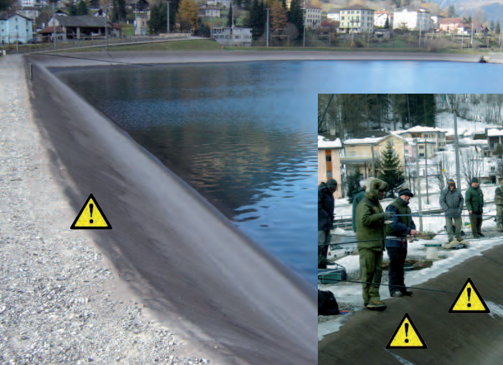
Fig. 3 - Rive artificiali lisce con pendenza molto elevata, sempre particolarmente scivolose. Il pericolo aumenta ulteriormente in caso di pioggia o gelo.
