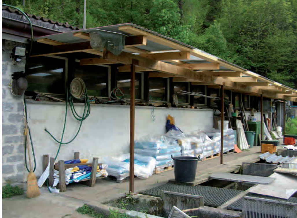
Nuova tettoia per il mangime allo stabilimento di piscicoltura a Rodi.
