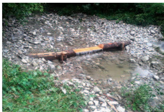
I lavori effettuati nel torrente Gaggiolo.
