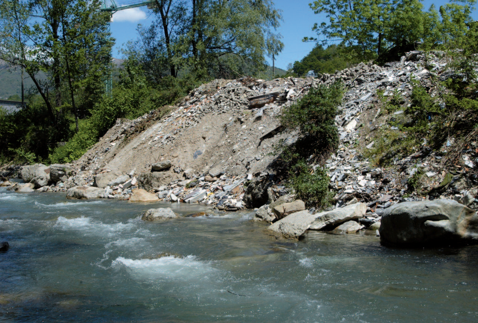
A sinistra il «nuovo Cassarate» dopo gli importanti lavori di riqualifica alla Stampa, a destra la stessa zona prima dei lavori.
