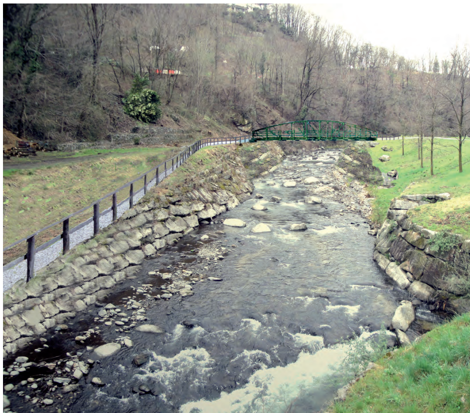
Ricostruzione fotografica (ad opera di Luini Tunesi, Ingegneria SA, di Lugano-Pre-gassona) della passerella che è in fase di realizzazione.
