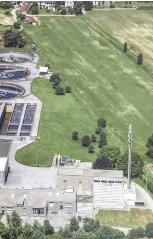
A sinistra: veduta aerea dell'impianto di depurazione alla foce della Maggia (foto CDV).
