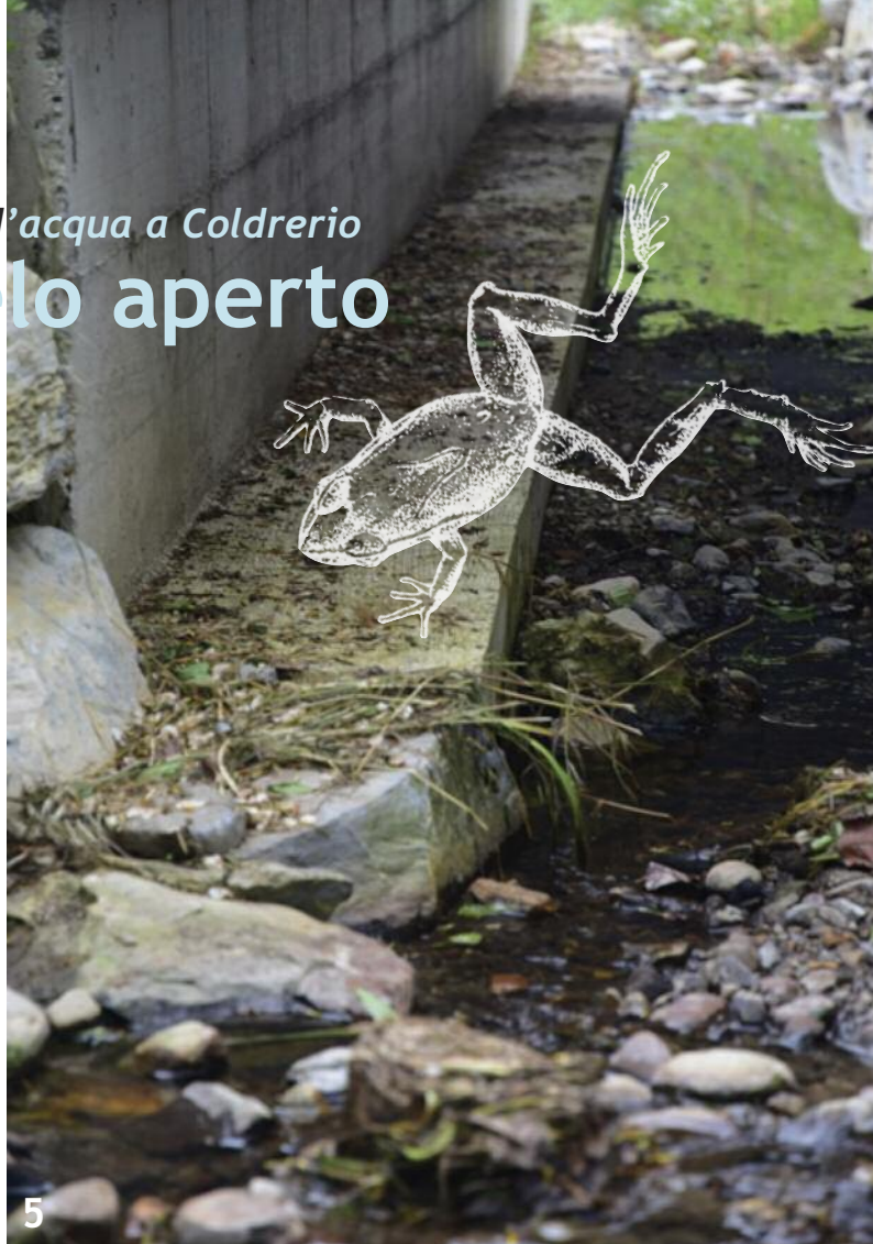
Sopra, figura 5, banchina laterale per il passaggio della piccola fauna (fotografia di Laura Bernasconi, Ufficio dei corsi d'acqua).
