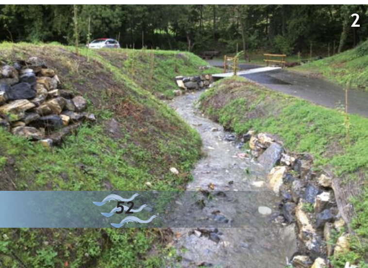
Figura 2 Grazie agli interventi di rivitalizzazione, il riale Vigino ha ritrovato un nuovo tracciato a cielo aperto, un alveo e delle rive naturali. Sulla sinistra, è visibile la struttura (pietraia) realizzata come rifugio per la fauna (rettile) (fotografia di Laura Bernasconi, Ufficio dei corsi d'acqua).
