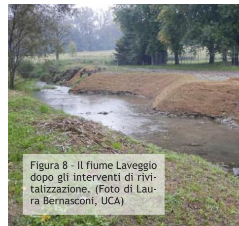
Figura 9 - Il fiume Lavaggio: esempio di realizzazione di una rampa a pendenza dolce. (Foto di Laura Bernasconi, UCA)
