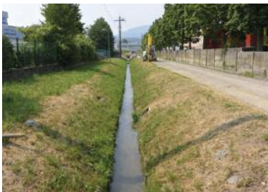
Figura 1 - Il riale Gurungun prima degli interventi di rivitalizzazione. Il consolidamento dell'alveo, le sponde artificiali, la variabilità nulla della larghezza e la profondità dell'acqua erano i principali deficit ecologici. (Foto di Laura Bernasconi, UCA)
