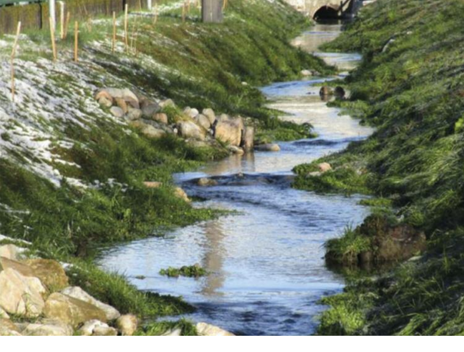
Figura 3 - Grazie agli interventi di rivitalizzazione, il riale Gurungun è stato allargato, mentre le sue sponde sono state rese più dolci e naturali. (Foto di Samuele Bonacina, comal.ch)
