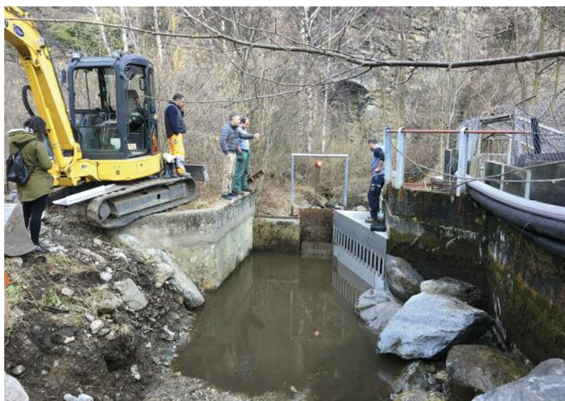
Posa della nuova struttura di griglie nella presa dell'acqua a nord della piscicoltura (foto di Michele Ceresa).
