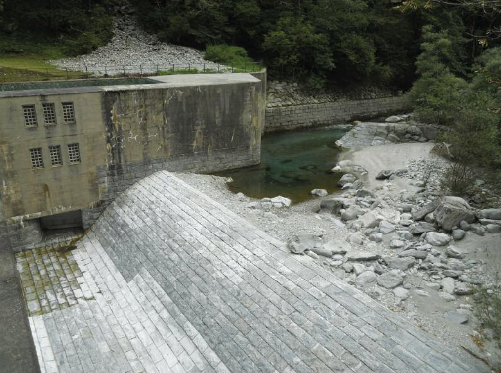
La presa Bavona 1. Una delle prese interessate dal progetto di aumento dei deflussi rilasciati a valle.
