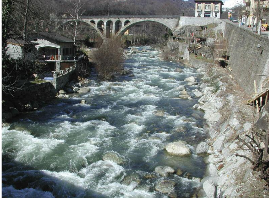
Fiume Ticino a Giornico in un momento con le prese dell'idroelettrico fuori servizio.
