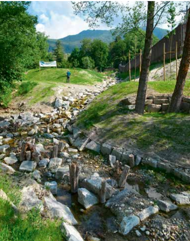
A conclusione dei lavori (maggio 2020).
