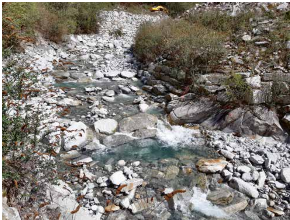
La Maira come si presenta attualmente dopo gli interventi di messa in sicurezza. Per garantire una strutturazione in tempi brevi dell'alveo del fiume è stata organizzata una piena artificiale, in accordo con l'Ufficio per la caccia e la pesca e in collaborazione con le officine idroelettriche. Ai piedi delle brevi rampe in blocchi si sono formate le caratteristiche pozze. Si osserva inoltre la struttura del deflusso lungo la rampa, con la formazione di diversi corridoi di risalita.
