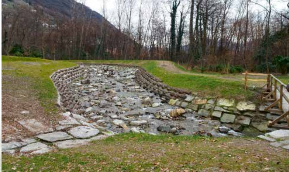
Il nuovo alveo allargato e strutturato, poco dopo il termine dei lavori (stato a gennaio 2020).
