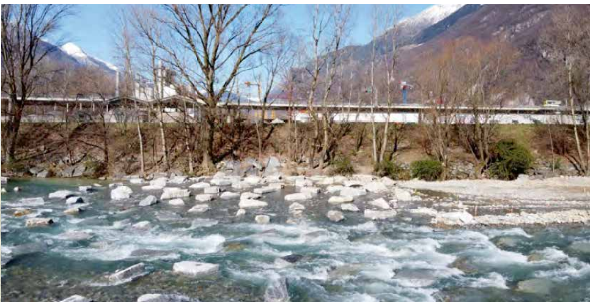
Per le immagini al centro e in basso: nuova rampa della Moesa ad Arbedo. >>
