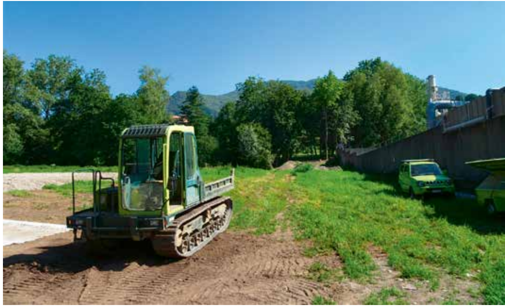
All'inizio dei lavori il corso d'acqua non esisteva ancora (giugno 2019).
