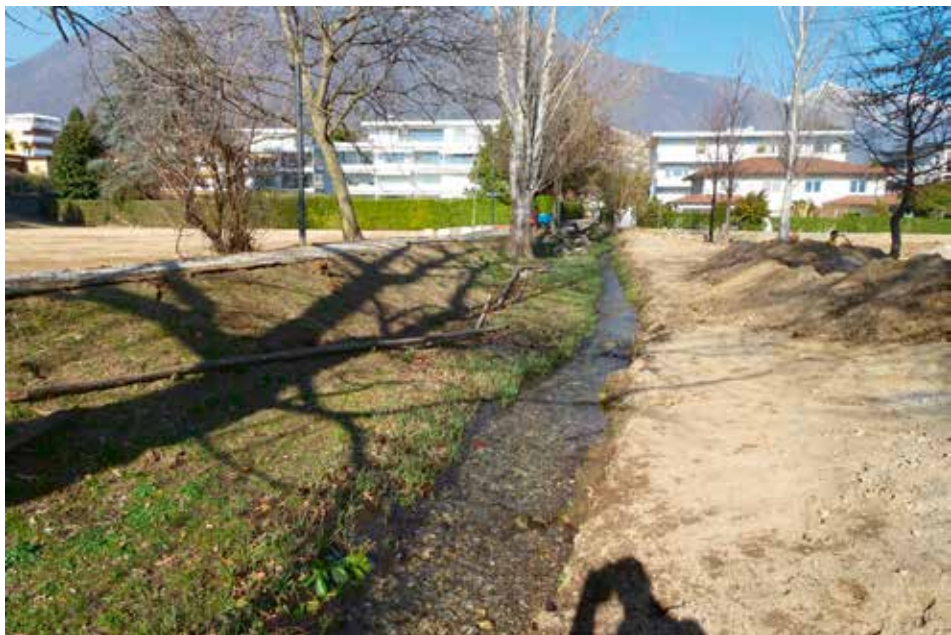
Inizio dei lavori nel febbraio 2019.
