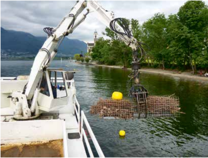
La posa di gabbie con fascine per alborelle nel Gambarogno, segnatamente lungo la riva da Magadino a Vira.
