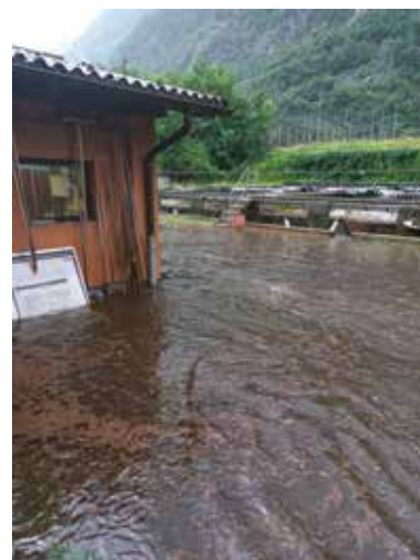
In presenza dell'alluvione dell'8 luglio, con seri danni anche all'incubatoio.
