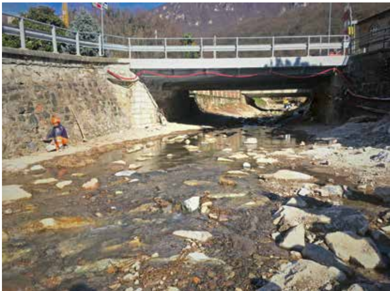
Dopo il risanamento della soglia a valle della strada cantonale e l'apertura del selciato con strutturazione dell'alveo del torrente.
