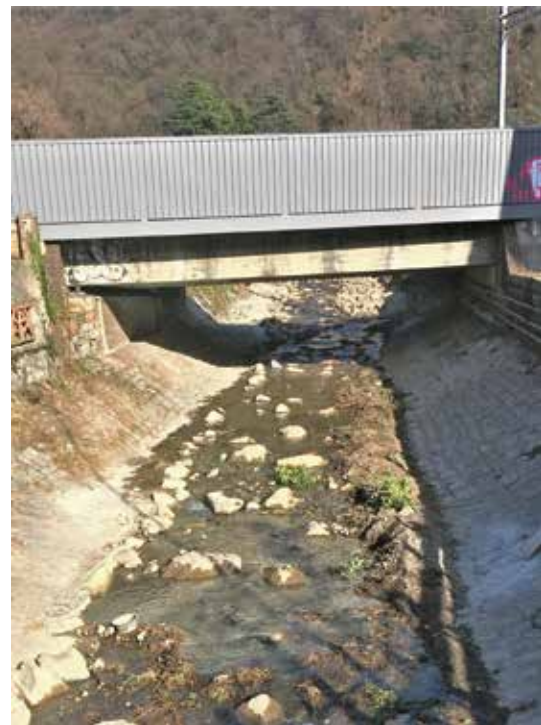
Apertura del selciato e strutturazione dell'alveo nella tratta tra la strada cantonale e la linea ferroviaria.
