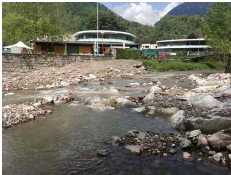
Risanamento del salto presso la foce con una rampa strutturata per ristabilire la libera migrazione ittica.
