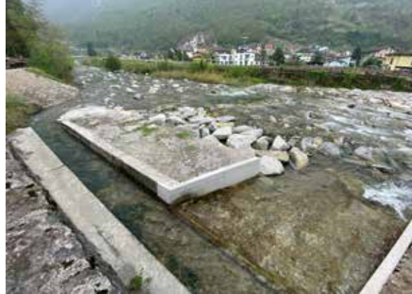
Sulla sinistra la roggia di Semione, sulla destra il nuovo piano di scorrimento a carattere naturale evitando così il salto che esisteva prima nel fiume Brenno (foto di Tiziano Putelli).
