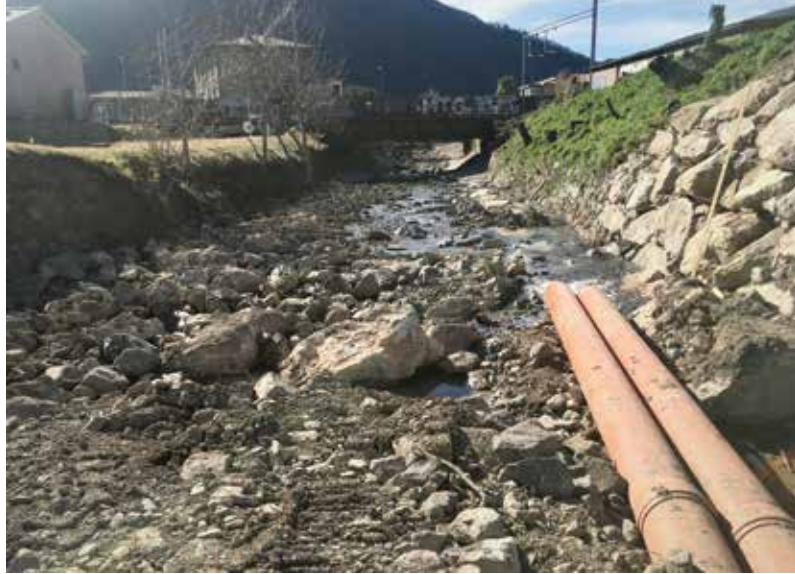
Lavori lungo la tratta finale a valle dell'allargamento in zona Mulino, a monte della linea ferroviaria.
