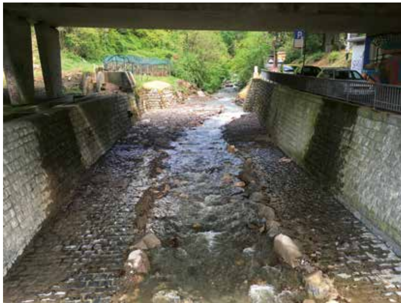
Apertura del selciato e strutturazione dell'alveo sotto al viadotto dell'autostrada.
