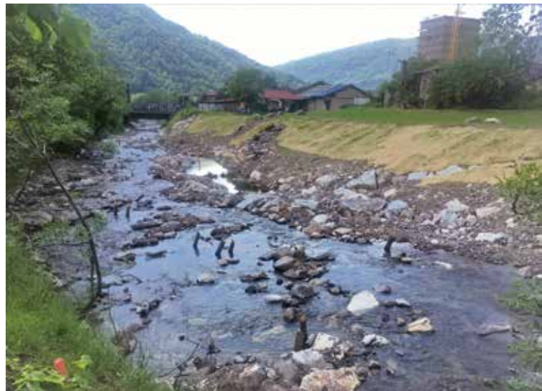
A sinistra, la situazione della zona Mulino prima dei lavori di rinaturazione in atto, vista da valle verso monte; a destra, situazione alla fine dei lavori di allargamento in zona Mulino, vista verso valle: l'alveo è stato strutturato con sassi e legname per favorire la dinamica e la diversità di habitat.
