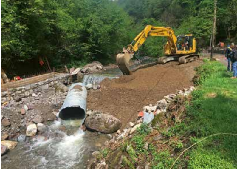
Risanamento in corso del salto all'altezza del cimitero / presa della roggia con una rampa strutturata per ristabilire la percorribilità longitudinale della fauna acquatica. La deviazione delle acque, durante i lavori, permette di limitare il più possibile l'intorbidimento delle acque.
