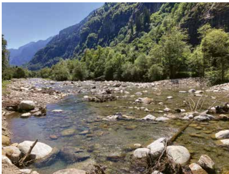
L'allargamento dell'alveo del fiume Ticino; sulla destra, i pennelli spondali a protezione della sponda destra.
