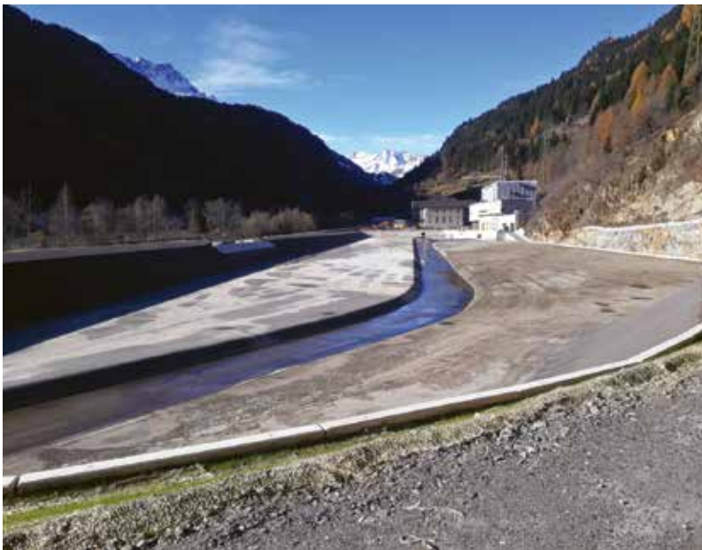
Veduta da sud del bacino di demodulazione (foto di Roberto Alberti).
