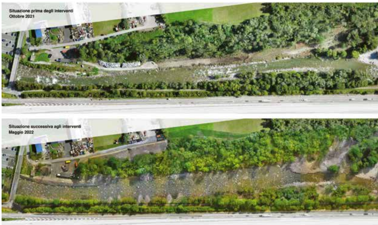
La situazione prima e dopo gli interventi sul fiume a Chiggogna.
