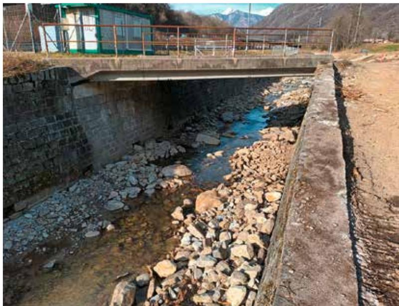
Lungo il torrente, rampa di risalita ittica in pietrame realizzata nei pressi della foce (foto di Marco Somaschini).
