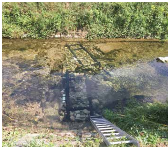
Antenne PIT tag installate nel Laveggio.
