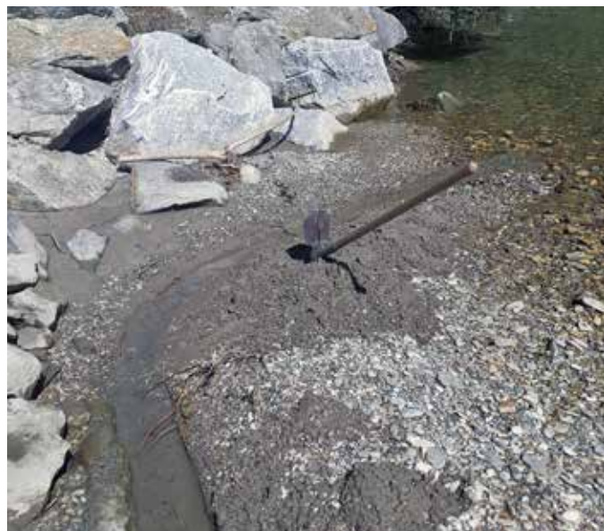
Creazione di canali per dare acqua alle pozze laterali.
