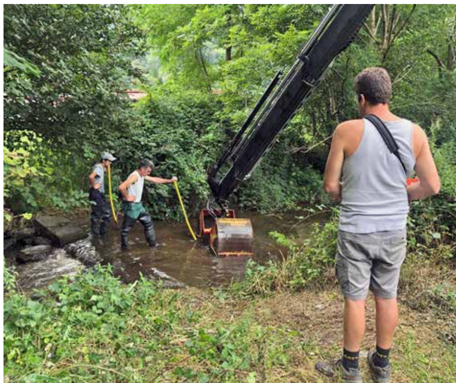
Manutenzione delle prese d'acqua (foto di Michele Ceresa).
