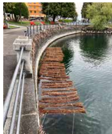
Le fascine, ancorate al muro, a Muralto, sul lungolago di Burbaglio (foto di Ivan Pedrazzi).
