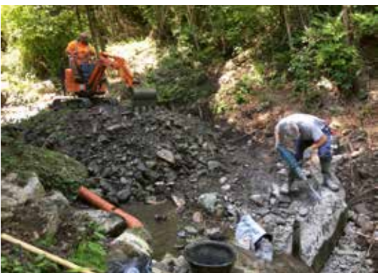
Lavori di miglioria alla sorgente del riale Brima.
