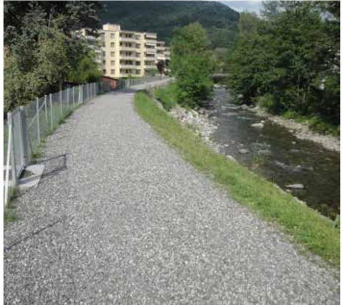
Lotto 4B – L'argine orografico destro realizzato a Tavernes, durante i lavori eseguiti tra il 2011 e il 2013, permette di contenere le piene del fiume e consente il transito della mobilità lenta (foto del giugno 2014).
