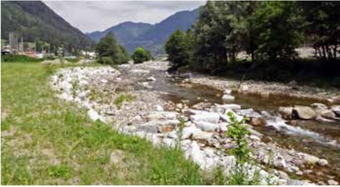
Il grande allargamento della sezione del fiume a Rodi. Sullo sfondo, si possono vedere anche le isole artificiali.
