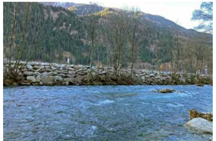
L'arginatura è stata portata in quota di protezione e la strada d'argine riprofilata.
