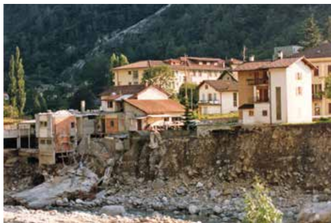
Altra immagine dello sconquasso procurato dall'alluvione in Blenio, ad Acquarossa.
