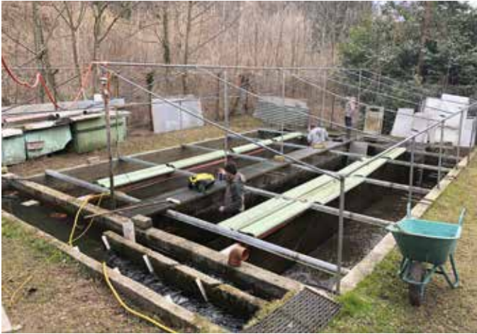
Lavori di manutenzione nelle vasche nel 2021.
